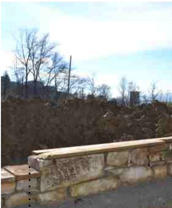
realizzazione muro in pietra facciavista
